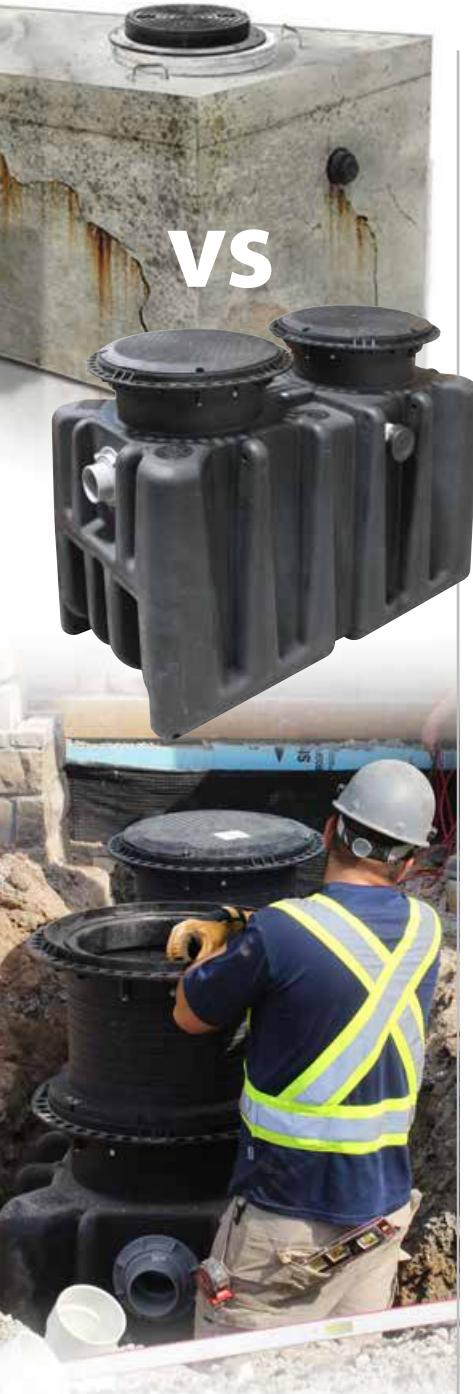
Les intercepteurs de graisse hydromécaniques (HGI) offrent une meilleure technologie et une meilleure efficacité que les GGI. Pour être certifiés, les HGI doivent se conformer à des normes d'essai très strictes, ce qui se traduit par une gestion optimale des graisses. Les tailles plus petites permettent des installations plus polyvalentes et nécessitent un entretien régulier, ce qui signifie que les déchets retirés sont moins toxiques et donc moins nocifs pour l'environnement.
